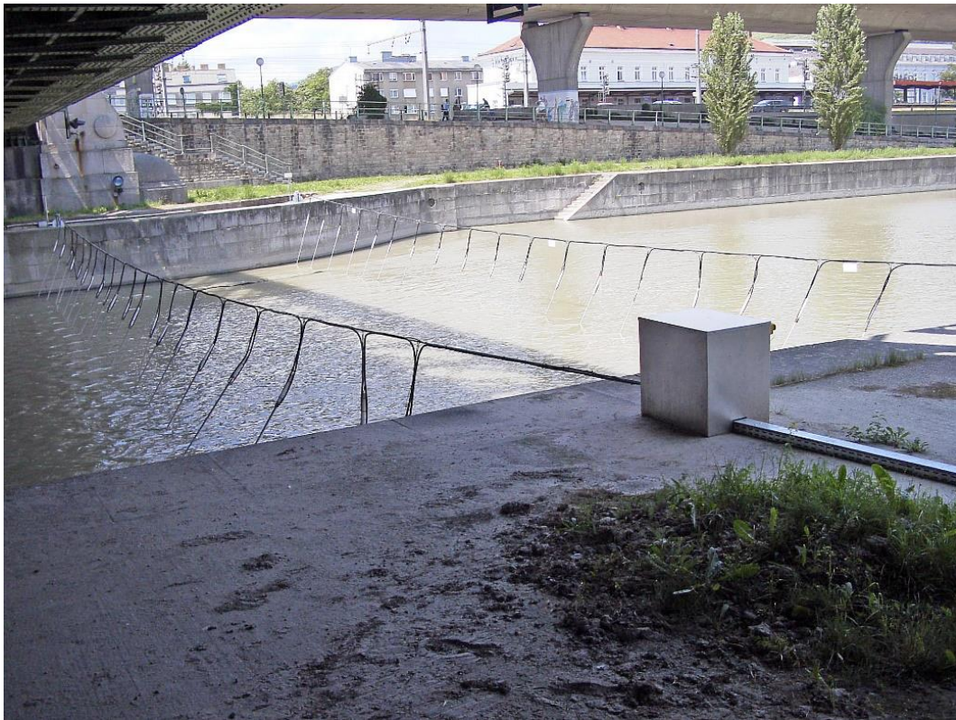
Bild 9: Abgehängte Elektroden vor der Schleuße des Wasserkraftwerks Nussdorf in Wien.
