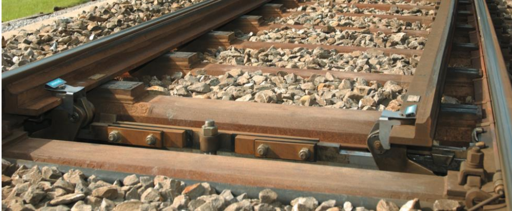
Abbildung 11 In eine Weiche installierter Klinkenverschluss [37]
