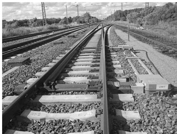
Abbildung 5 Weiche mit Doppelgestänge (rechts) [2]
