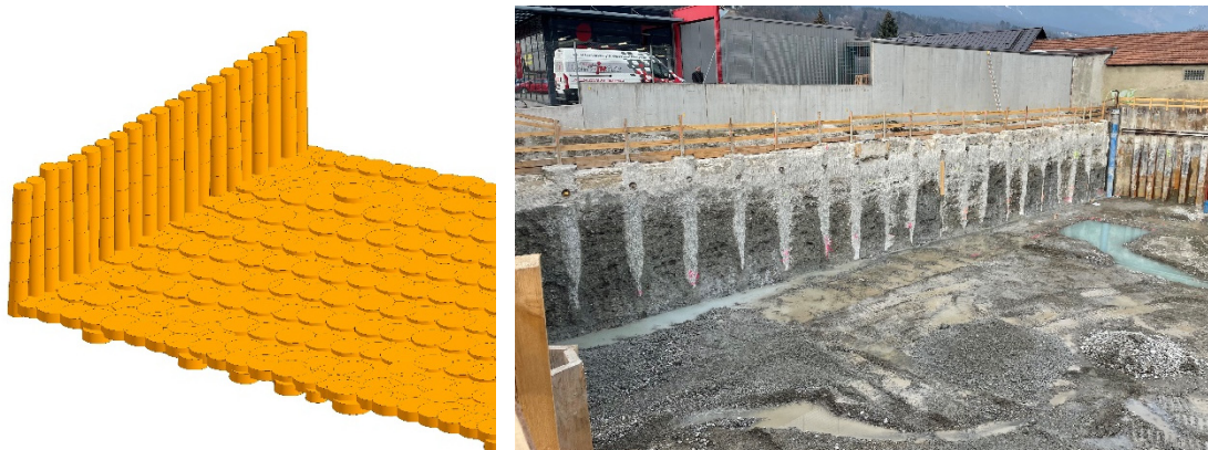
Abb. 6: Vergleich 3D As-built Model und fertige Baugrube
