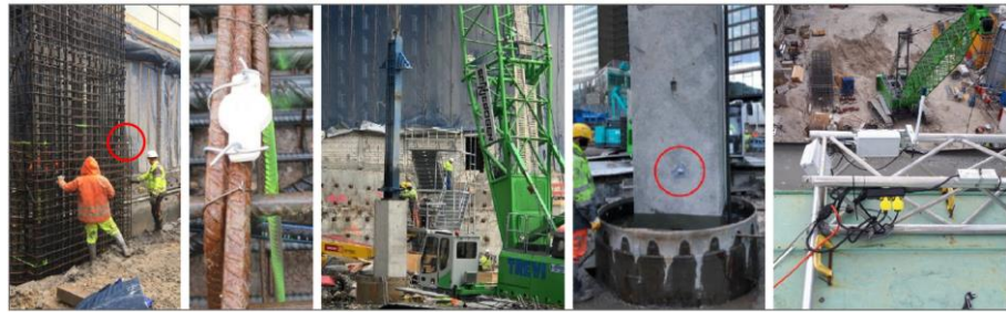
Abbildung 6.8 Einbau Bewehrungskorb und Stütze mit Neigungssensor 192
