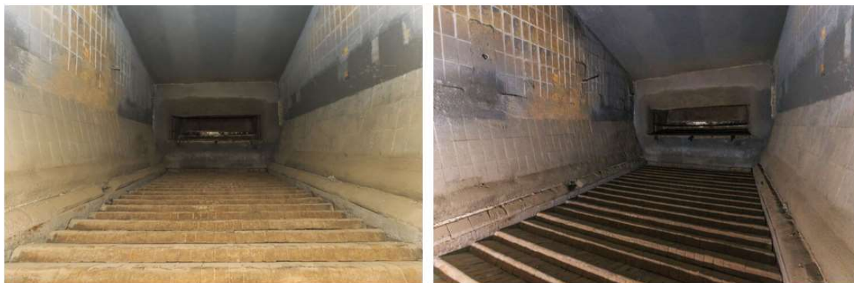
Abbildung 29: Dreistufiger Vorschubrost der MVA Hamm, Bildquelle [52].
