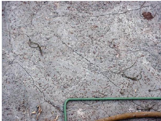
Abbildung 2.13: Spannungsrisse an der Oberfläche [13]
