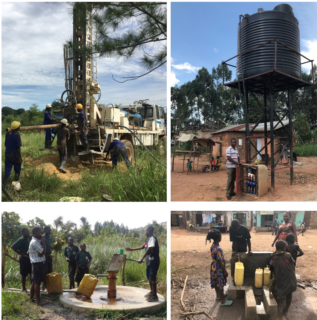
Abb. 6: Bohrbrunnen mit Handpumpe, oder mit Elektropumpe, Wasserturm und Zapfstelle (Kindern eine Chance, 2023)
