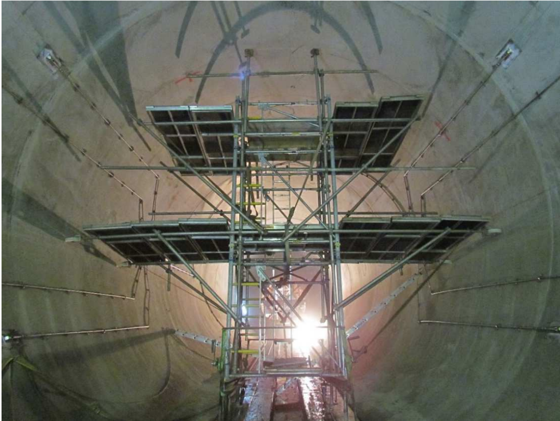
Abbildung 1.3: Einbau einer Ultraschall-Messstrecke
