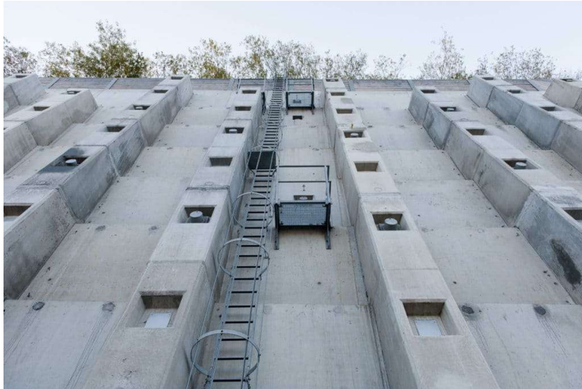
Abb. 20: Ankernischen in vertikalen Lisenen (Haiderbau, 2022)
