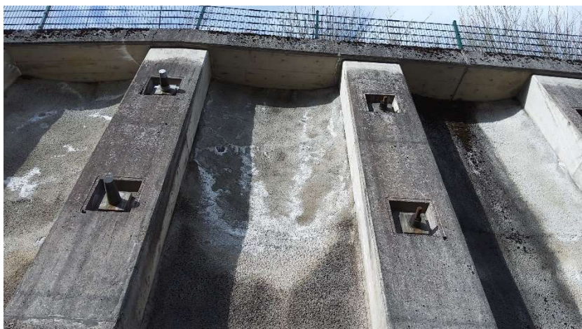
Abb. 21: Spritzbetonausfachung
