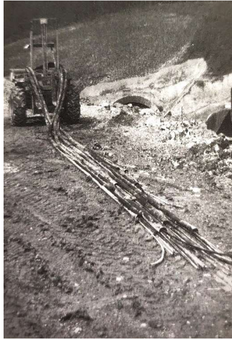
Abb. 43: Beispiel für den unsachgemäßen Transport auf der Baustelle (Wichter und Meininger, 2022)
