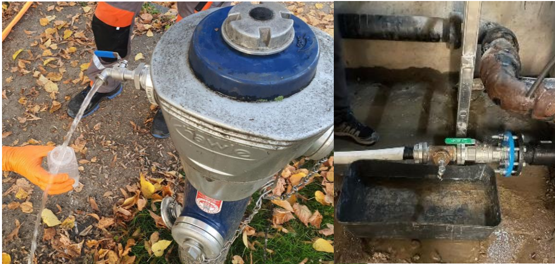
Abbildung 6-23: Probenahme am Hydranten (linkes Foto: Gruber) und der eingebaute Probenahmehahn am Punkt A (rechtes Foto).
