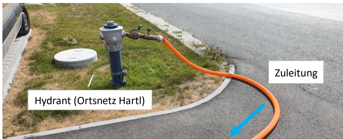
Abbildung 5-4: Anschlusspunkt Hydrant, Trinkwasser aus dem Ortsnetz von Hartl (Foto: Gruber, mod.).
