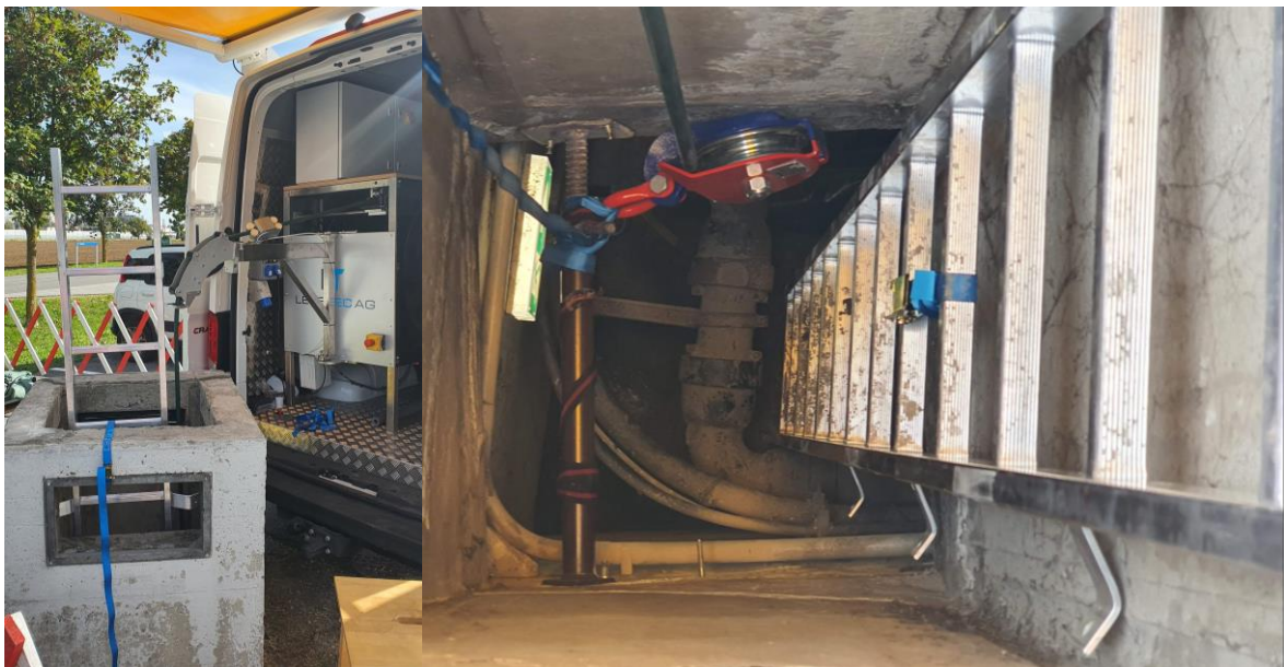
Abbildung 6-21: Einbringung des Lampenkopfes (linkes Foto) und Schachteinstieg in den Kollektorgang mit installierter Umlenkrolle (rechtes Foto) für den L.E.S.S.-Lampenkopf (Fotos: Gruber).
