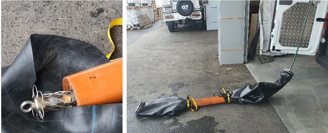
Abbildung 6-28: Der händisch eingebrachte L.E.S.S.-Lampenkopf (linkes Foto) vor der Installation der Schutzschleuse vor einer L.E.S.S.-Behandlung des Rohres und die Durchführung einer L.E.S.S.-UV-C-Behandlung (rechtes Foto) in einem kontaminierten TW-Rohr (Fotos: Gruber).
