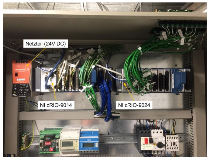
Abbildung 4-1: Anordnung der Steuereinheiten im Schaltschrank
