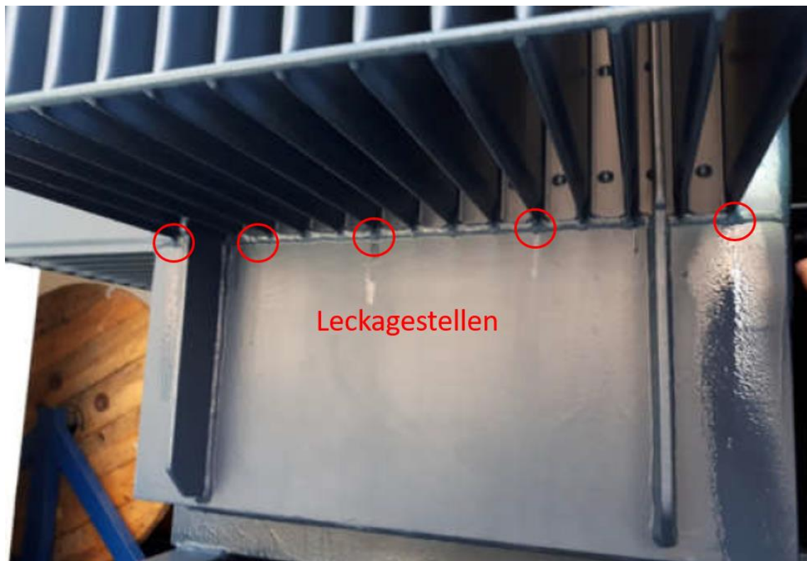
Abbildung 11: Schäden im Bereich 1 [1]
