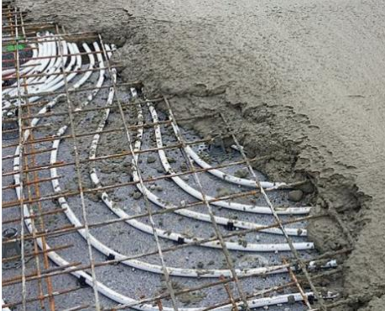
Bild 4.16 Zwischendecke mit Rohrregister zur Betonkernaktivierung 281
