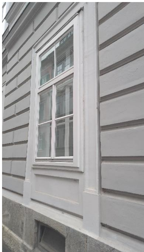
Abbildung 30: Kastenfenster im Erdgeschoß der Lessingstraße 27
